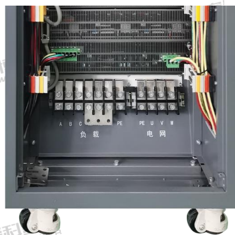
图 30 三相四线输出接线示意图
